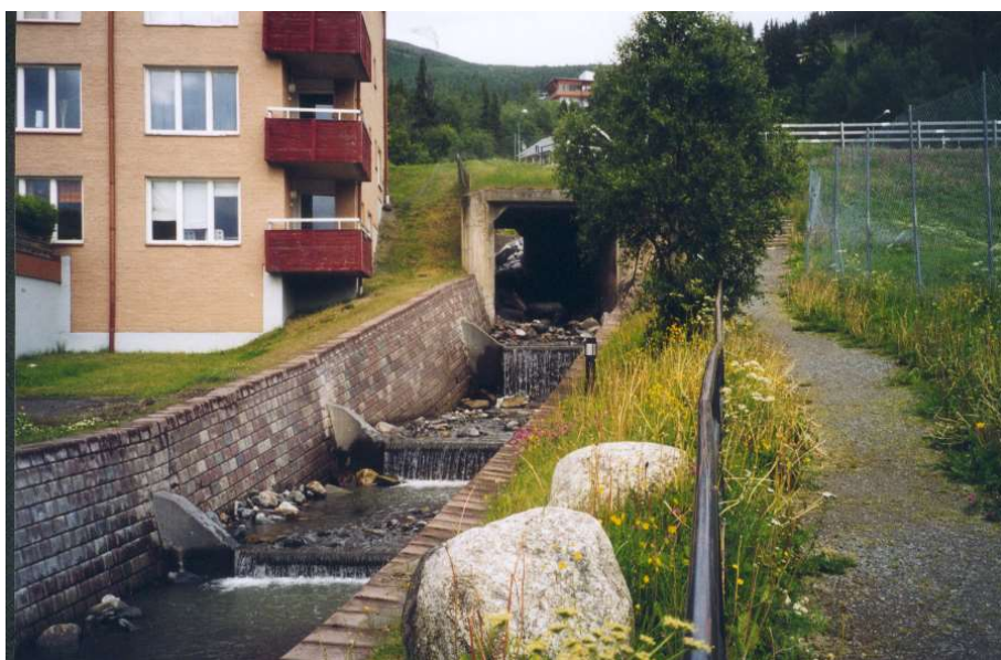
Figur 13. Erosionsdämpade trappor i Åre. Foto: SGI.
