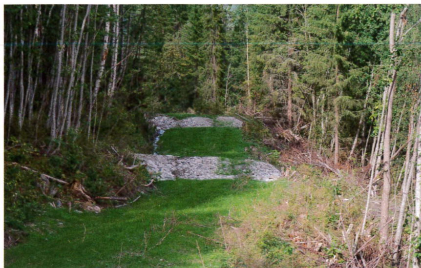
Figur 15. Breda korsdiken längs traktorväg i Norge. Leder vatten från vägdiken och vatten som rinner ner för vägen, ut på nedsläntsidan. Foto: Jonsson, NGI.
