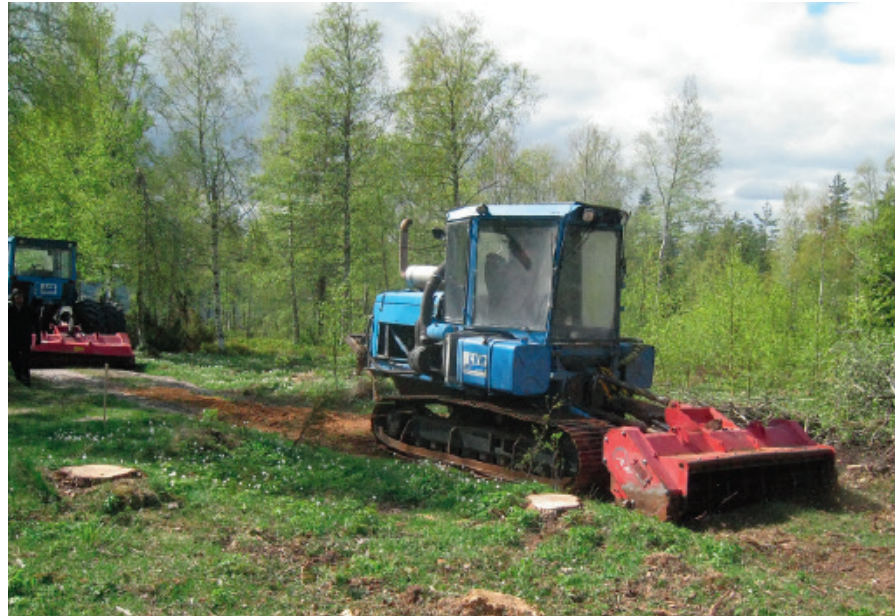
Sedan var det dags att med specialmaskiner fräsa stubbar och mark.
