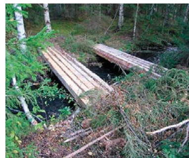
Stockmattor utlagda för överfart. Sådana kan även användas för att förstärka på- och avfart i anslutning till själva vattenpassagen.
