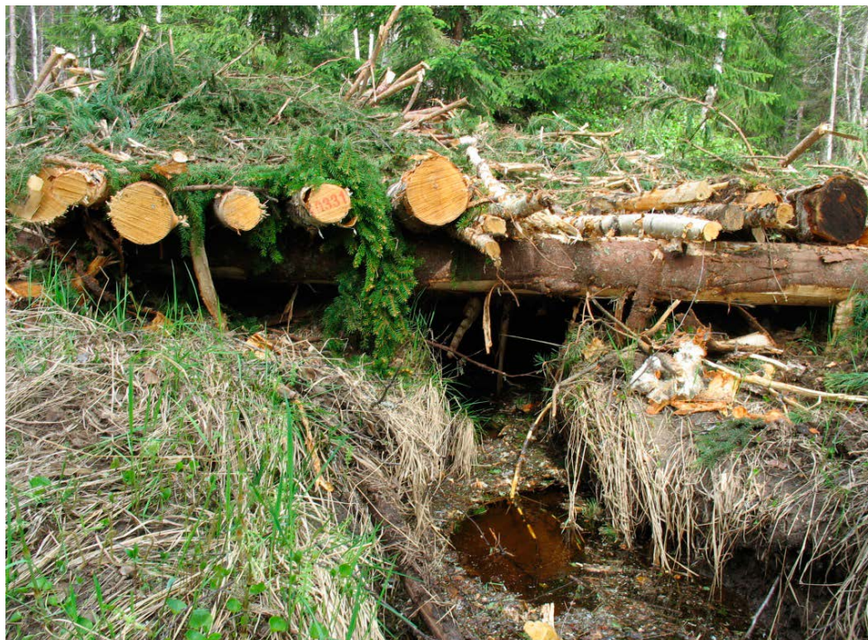
Figur SA17 Bäcköverfart med så kallad kavelbro, där stockar har använts för att bygga en tillfällig bro för att undvika att bäcken körs sönder. Grenar och toppar ovanpå stockarna ökar brons livslängd. Det stämplade numret på björkstocken visar att skotarföraren har hämtat virke från avlägg för att bygga kavelbron. Foto Ola Lindroos.
