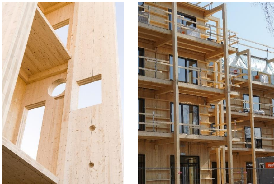
Figur V42 Korslimmat trä (KL-trä) ger möjligheter att tillverka stora monteringsfärdiga träelement effektivt i fabrik samtidigt som det möjliggör högre konstruktioner av flerfamiljshus och effektiviserar byggprocessen. Foto vänster: Martinsons /Jonas Westling. Foto höger: Lars Wilhelmsson.
