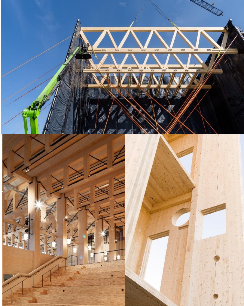
Figur VII Ökad efterfrågan på effektivt och miljövänligt producerade flervångshus i trä har lett till en kraftig ökning av träbaserade konstruktionselement som limträbalkar (överst och i taket nere till vänster) och korslimmade väggelement (KLT) (nere till höger). Foto: Sara kulturhus i Skellefteå och Martinsons Trä.
