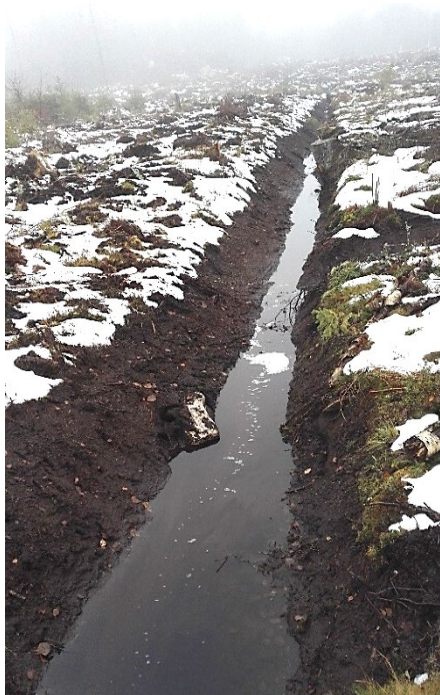
Figur 13. Dikesrensning medför ökad transport av slam som bland annat innehåller organiskt material. Eftersom metylkvicksilver och kvicksilver binder starkt till organiskt material, medför dikesrensning även en ökad transport av dessa ämnen. Foto: Anja Lomander.
