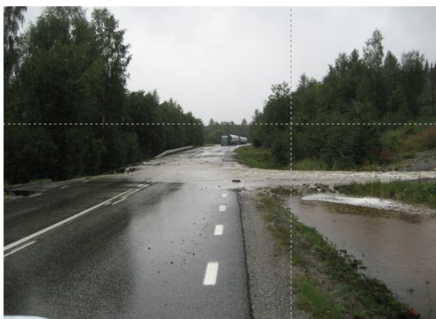
Figur 46. Foto över skada 1 (se karta i figur 45 ovan). Vatten strömmar från anslutande skogsbilväg över vägen och transporten av ett vindkraftverk syns i bakgrunden. Foto: Stefan Johansson, Trafikverket
