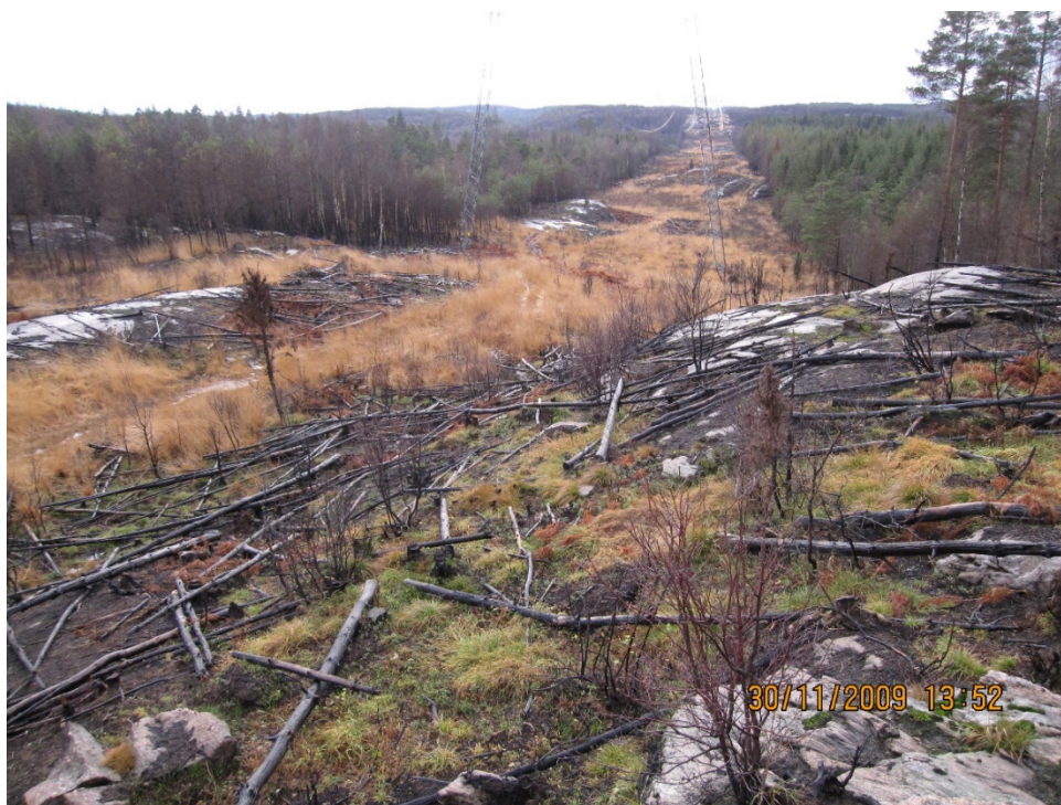
Figur 69. Kraftledningsgata som påverkats av brand. Notera de kvarlämnade röjningsresterna som utgjort bränsle till branden. Denna kraftledningsgata korsades av en mindre ledningsgata med trästolpar. Foto: Leif Sandahl, MSB.
