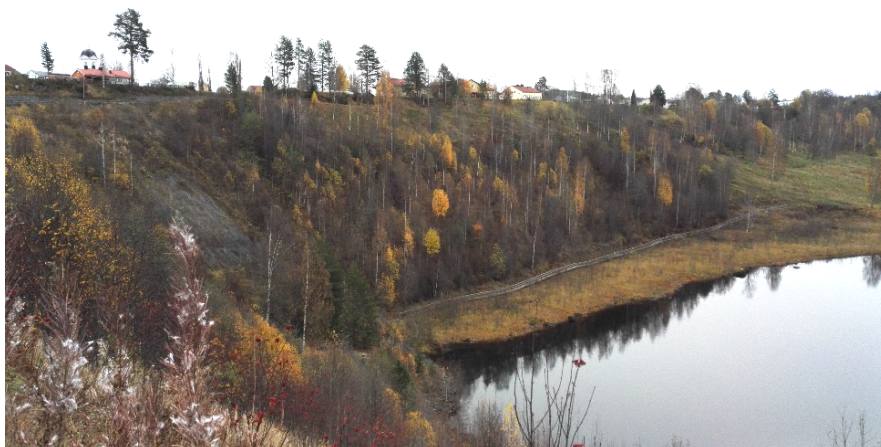
Figur 12. Exempel på ett område med hög risk för erosion och ras. En avverkning som resulterar i att alla träd avlägsnas från slänten ökar sannolikheten för att slänten ska rasa och konsekvensen kan betecknas som stor då villorna längst uppe på släntkrönet kan dras med av raset. Foto: A. Lomander
