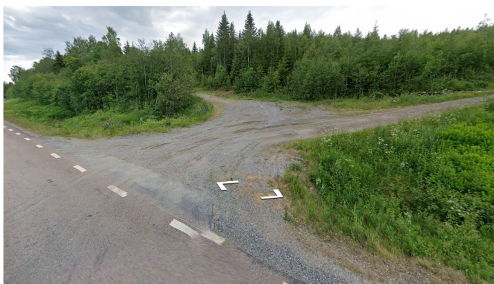
Figur 46. Foto över skada 1 (se karta i figur 45 ovan). Vatten strömmar från anslutande skogsbilväg över vägen och transporten av ett vindkraftverk syns i bakgrunden. Foto: Stefan Johansson, Trafikverket
