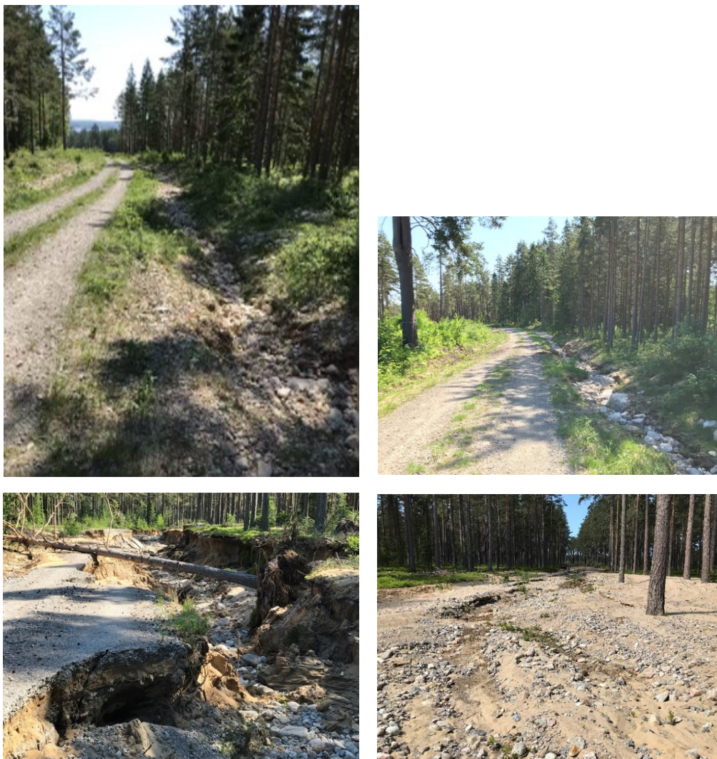
Figur 60. Uppifrån och ned visar bilderna hur vatten, från att ha runnit och eroderat vägdiket, längre ned i slänten spolat bort hela vägen. Bilden längst ned till höger visar delar av sanden som avsatts i ett tallbestånd. Foton: S. Gunnarsson, Skogsstyrelsen.
