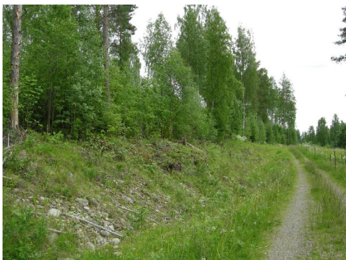
Figur 30. Långt vägdike som samlar vatten från en 14,5 ha stor avverkning och koncentrerar det till ett fåtal vägtrummor och därefter vidare ned i den mycket branta slänten.
