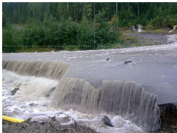
Figur 47. Översta bilden visar de båda skogsbilvägarnas anslutning ned mot väg 348. Nere till vänster ses hur vägdiket fyllts av vatten och till höger ses hur vattenmassorna spolat sönder vägbanan. Foton: Stefan Johansson, Trafikverket.
