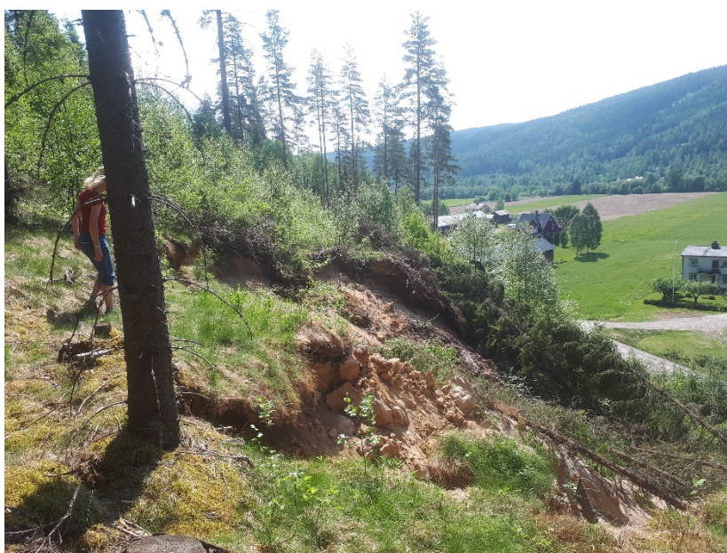
Figur 23. Klarälvsdalen. Ett koncentrerat vattenflöde genom en liten trumma har orsakat ett ras av slänten ned på väg 62 vid Enarbol. Foto: A. Lomander, Skogsstyrelsen
