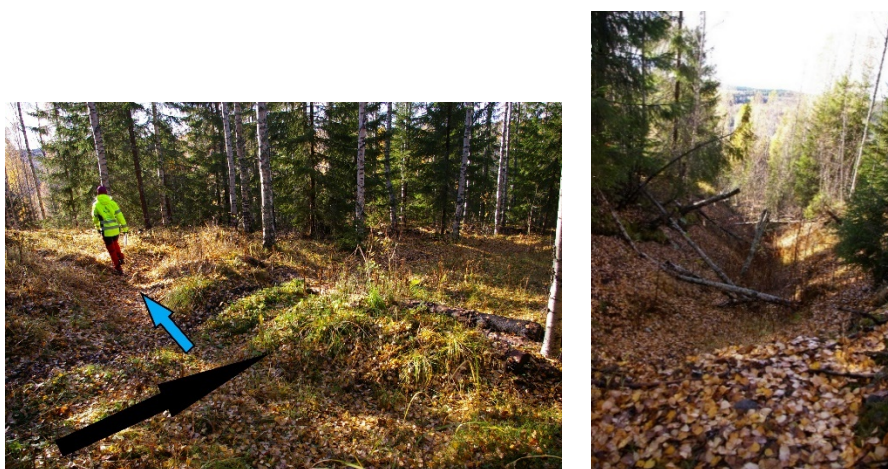
Figur 38. Vatten som rinner längs basvägen (svart pil) bromsas och leds av genom högar av timmer och jord som är upplagt tvärs över basvägen. Vattnet (blå pil) fördelas på detta sätt ut i terrängen och belastar inte ravinen (vänster foto). Vegetation får på så sätt lättare att etableras på nytt i ravinen och bromsa processen (höger bild). Foton: A. Lomander, Skogsstyrelsen.
