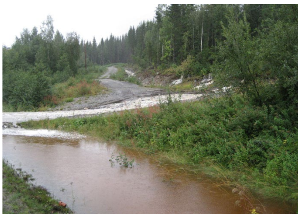
Figur 47. Översta bilden visar de båda skogsbilvägarnas anslutning ned mot väg 348. Nere till vänster ses hur vägdiket fyllts av vatten och till höger ses hur vattenmassorna spolat sönder vägbanan. Foton: Stefan Johansson, Trafikverket.
