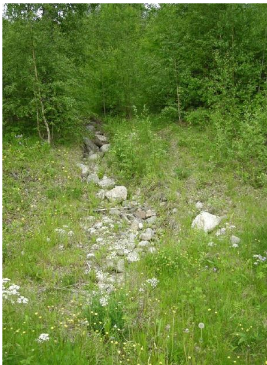
Figur 29. Kraftig erosion i gammal basväg som korsar vägdiket.
