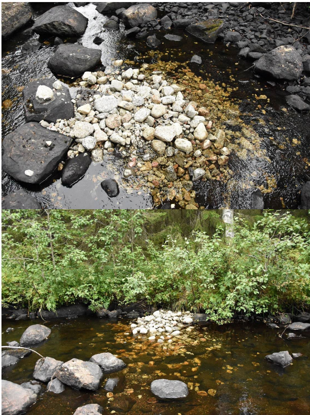
Figur 6. Utlagt grus från två platser i Orrbodån. Majoritet av det utlagda materialet var av för grov fraktion. Totalt hittades 22 liknande platser i Orrbodån med nyligen utlagt grus.
