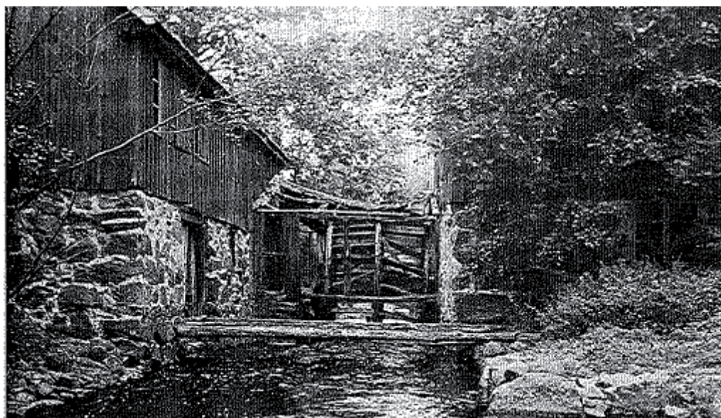
Historisk bild 1. Jämför med Bild 7 ovan. Bilden är tagen mellan åren 1915 och 1953. Taket över kvarnhjulet är nästan helt borta, medan vattenhjulet fortfarande finns kvar, om än i dåligt skick. Foto: Asarums sockenbok.
