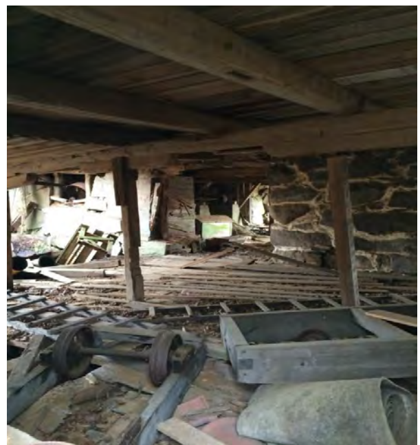
Bild 9. Interiört i sågverksbyggnaden.
