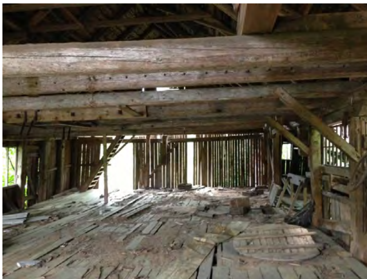
Bild 10. Interiört i sågverksbyggnaden.
