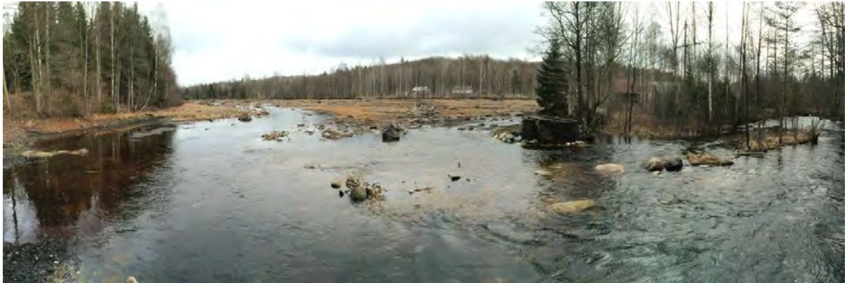
Bild 5. Vy över Hakafors damms utseende efter utrivningen.
