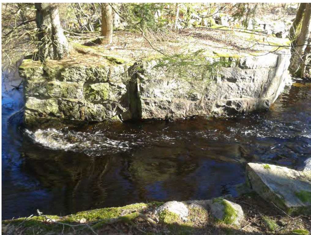
Bild 4. Här har en av dammluckorna suttit fästa.
