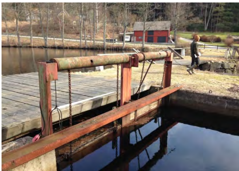
Bild 6. Intaget till turbinen regleras med en spelanordning.
