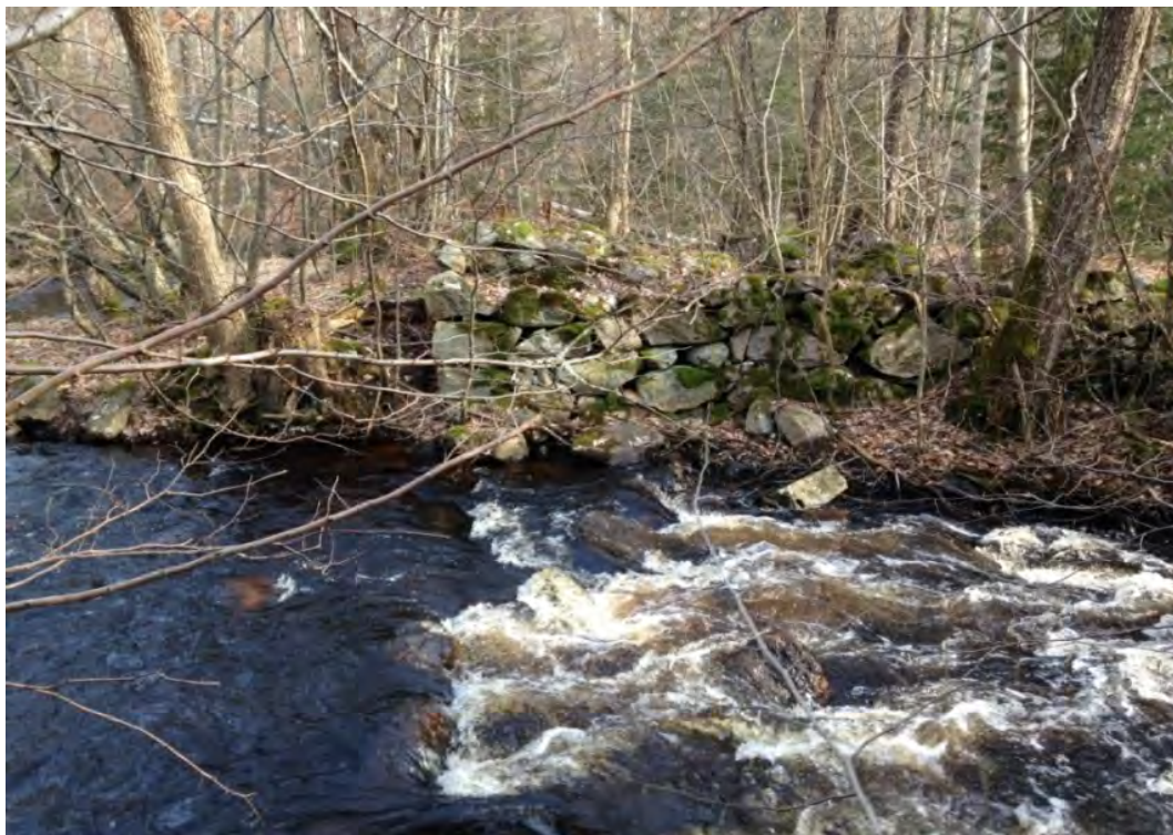
Bild 2. På andra sidan är lämningar efter kvarnbyggnaden samt kvarnfallet bevarat. Bilden är tagen från det västra dammfästet.
