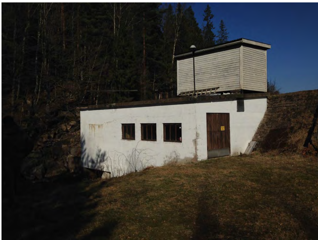
Bild 6. Kraftverket bakifrån. Den vita träbyggnaden ovanpå innehåller kombinerat kontor/maskinistrum. Den mäktiga dammvallen syns till höger om kraftverket. Här syns också den kraftiga stenskoningen.
