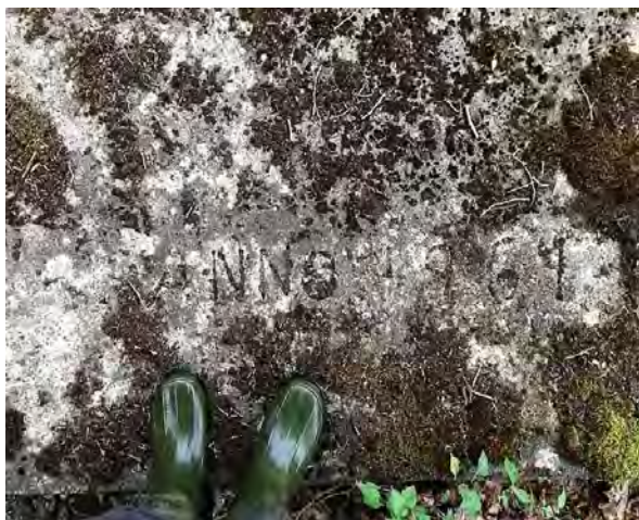
Bild 12. Dammbyggnaden renoverades sista gången 1964.
