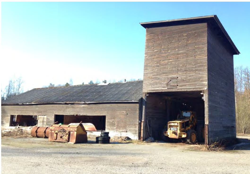
Bild 5. Hyvleriet är uppfört på 1960-talet.
