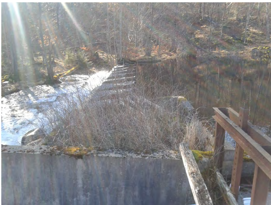
Bild 3. Skibord vid dammvallens östra sida. Dammanläggningen har ett tillstånd från 1949.
