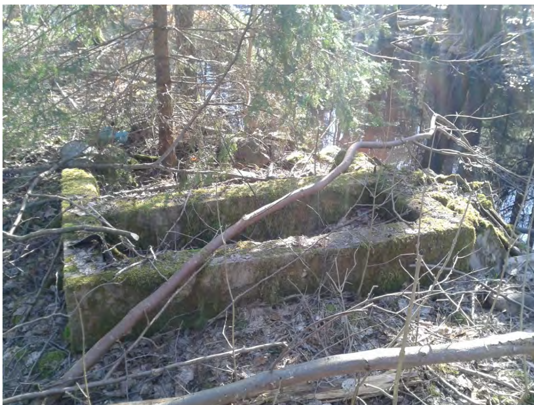
Bild 1. Grund efter en liten anläggning söder om inhägnaden, invid Mieåns östra strandkant. Troligen efter ett pumphus eller annat litet verk. Av cement, cirka 2 x 1,5 meter stor.
