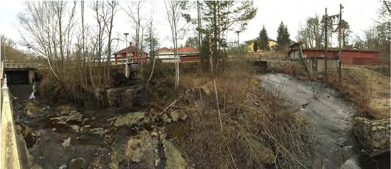
Bild 5. Dammbyggnad vid övre bruket från nedströmssidan.
