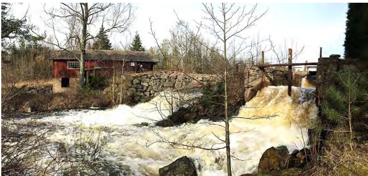
Bild 4. Dammbyggnad vid Norra Hoka. Det närmsta utskovet i bild var till den tidigare kvarnens turbinsump.
