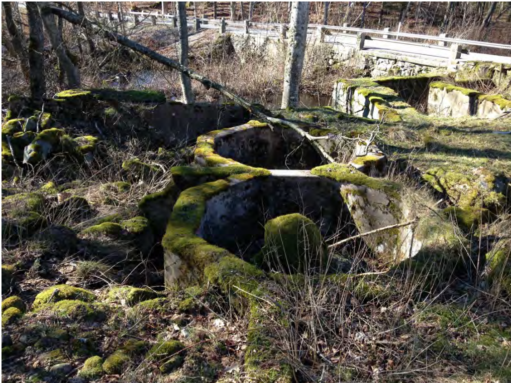
Bild 2. Detaljbild av stärlsefabriken. Stenvalvsbron skymtar i bakgrunden.
