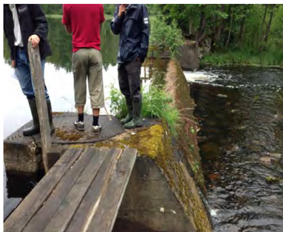
Bild 13. Före utrivningen av dammkroppens skibord.
