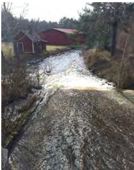
Bild 5. Det mellersta utskovet regleras med ett skibord.
