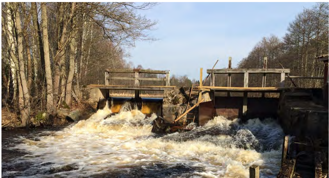
Bild 4. Dammbyggnaden vid Jeppshoka. Till vänster utskov med spel och till höger utskov med spettluckor.
