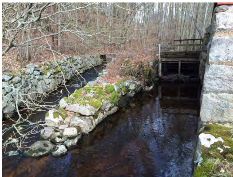
Bild 11. Den västra åfåran vid den äldre sågverksbyggnaden är stenskodd med hjulgrav och dammkropp. Till höger syns ålkistan.
