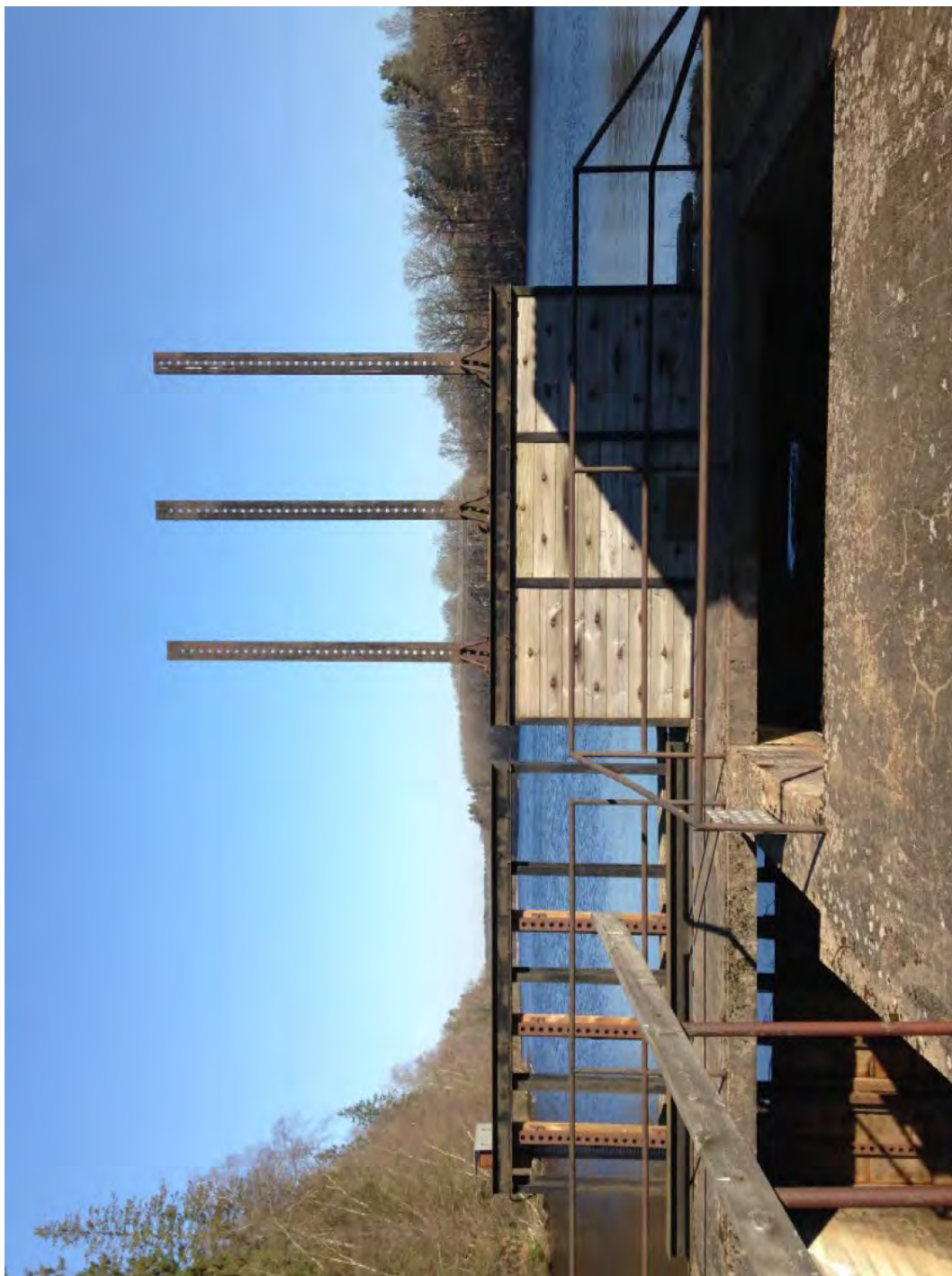
Bild 10. Dambyggnadens bottenutskov och intag regleras med respektive tre luckor med gåtar och ståndare i stål.
