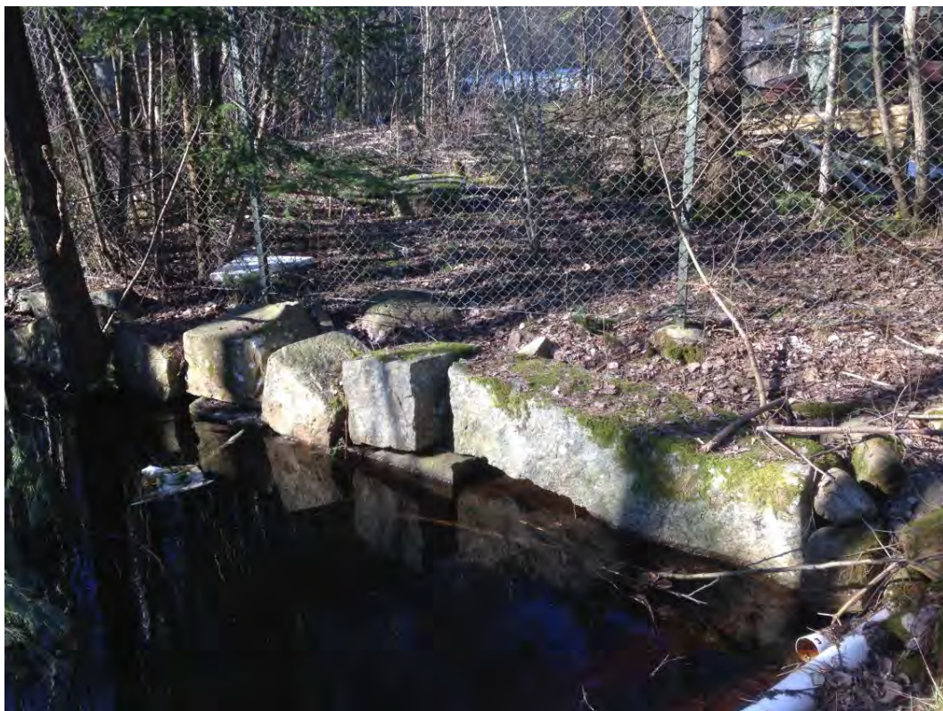
Bild 2. Den gamla åfåran genom sågen är nu igenfylld. Där den mynnar är den igenlagd med stora huggna stenblock.
