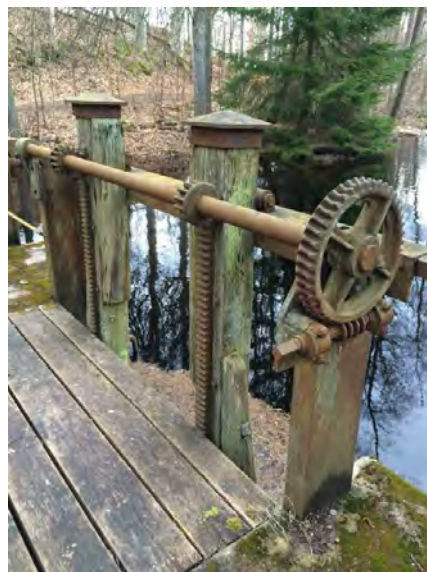
Bild 14. Det östra utskovet i den västra utskovsdammen regleras med spel och vevanordning avsedd för flottning.
