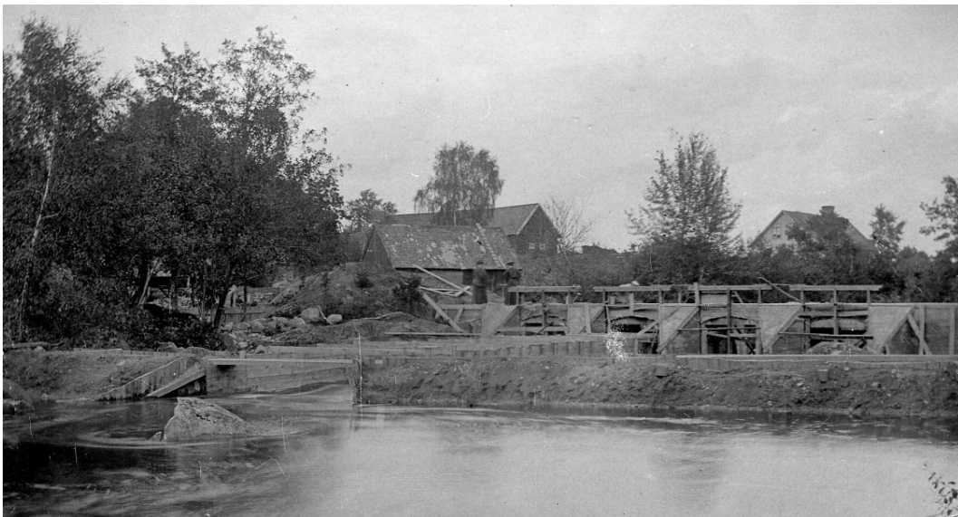
Historisk bild 2. Dammvallen under byggnation. På bilden syns att det rör sig om omfattande arbeten och större delen av den gamla dammvallen försvann säkert i detta arbete. Fotot taget från sydväst. Foto: Asarums hembygdsförening.
