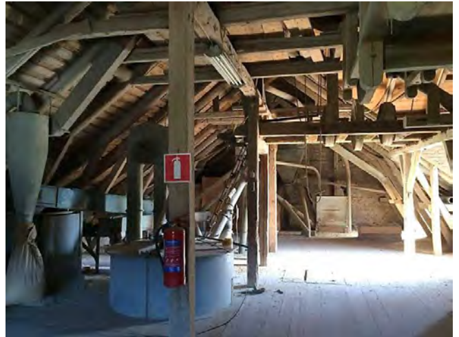
Bild 11. Interiört våning tre i kvarnbyggnaden från 1863.
