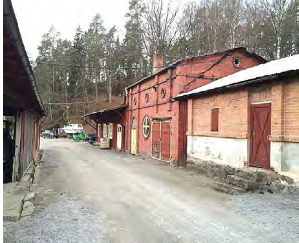
Bild 2. Bruksgatan. Gasverksbyggnaden intill snickeriet.
