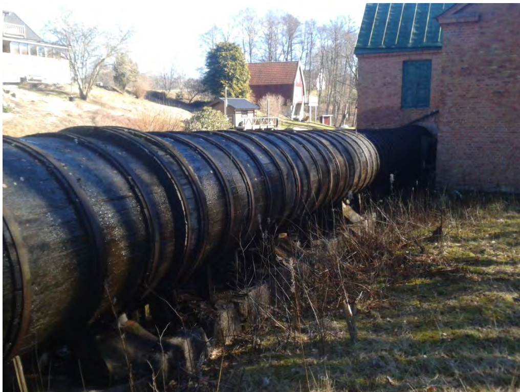
Bild 4. Trätuben till kraftverket har renoverats omsorgsfullt och är idag en av få bevarade trätuber i länet.
