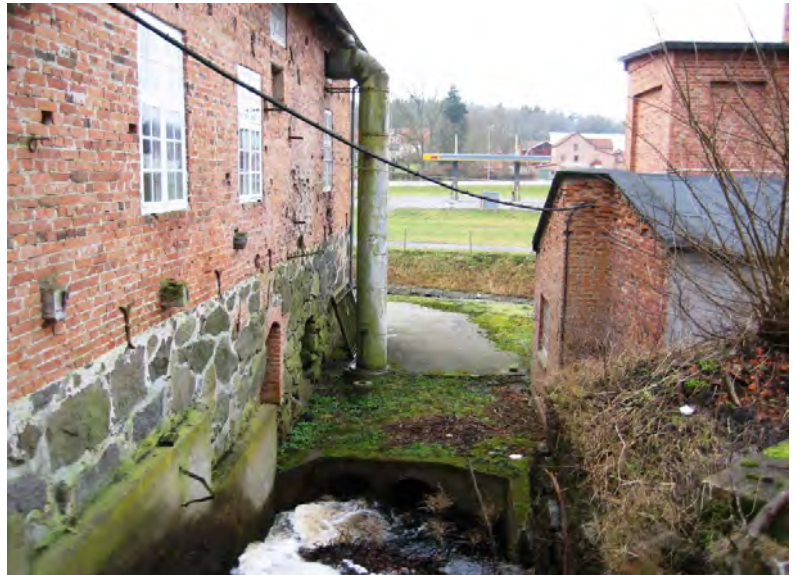
Bild 13. Kraftverksbyggnaden och den kulverterade hjulgraven intill kvarnbyggnaden. Foto: Petra Stråkendal 2009.
