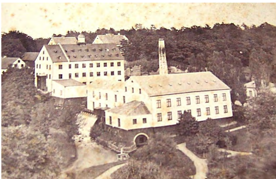
Historisk bild 3. Vy över spinneriet från sent 1800-tal eller tidigt 1900-tal. Notera att trätuben inte fanns utan en vattenränna med överfall försåg kraftverket med energi. Intill kraftverksbyggnaden är spinneribyggnaden och i bakgrunden väveribyggnaden. Fotografiet ägs av Karlshamns museum.
