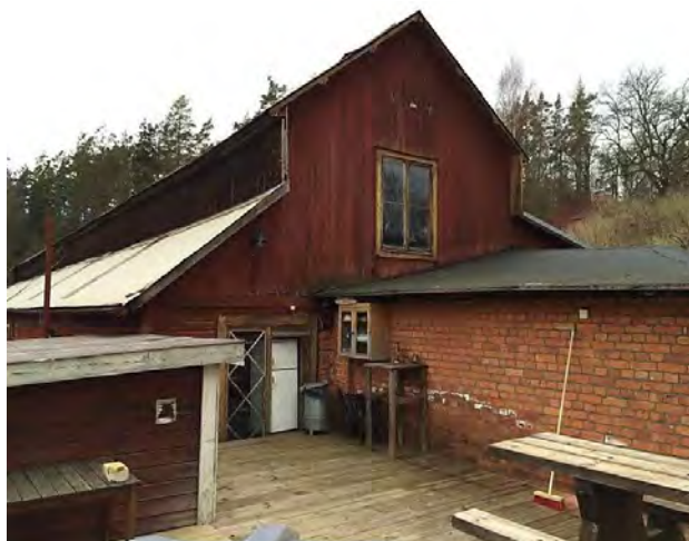
Bild 8. Valsverksbyggnaden var tidigare vattendriven.
