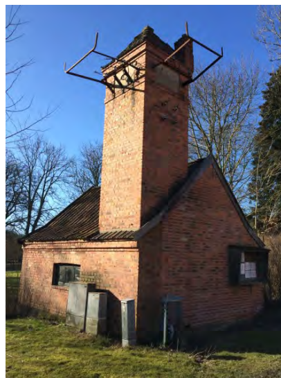
Bild 24. Transformatorstationen vid Jannebergs gård.
