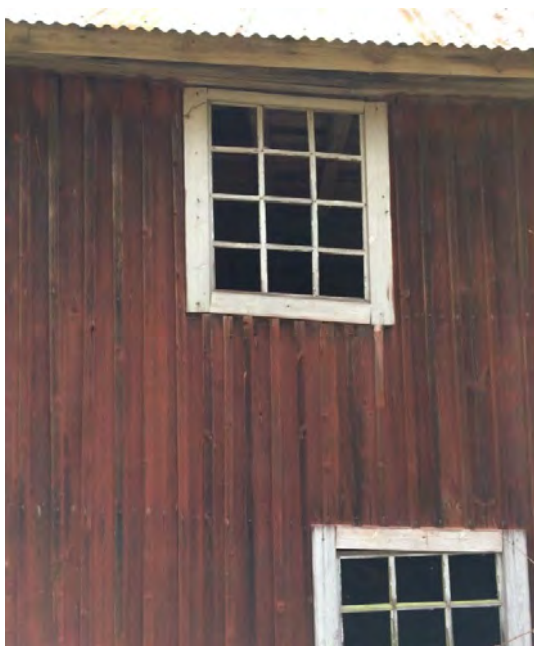
Bild 8. Småspröjsade enlufts-fönster i den västra fasaden.
