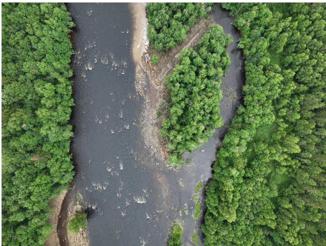
Figur 8. Överblicksbild (lodbild) från drönare på grävmaskin i arbete, Öreälvens huvudfåra. Här kan man se öns form, något som är svårt att avgöra från marken och därmed kan man enkelt göra korrigeringar om det behövs. Foto: Jonathan Nordin.
