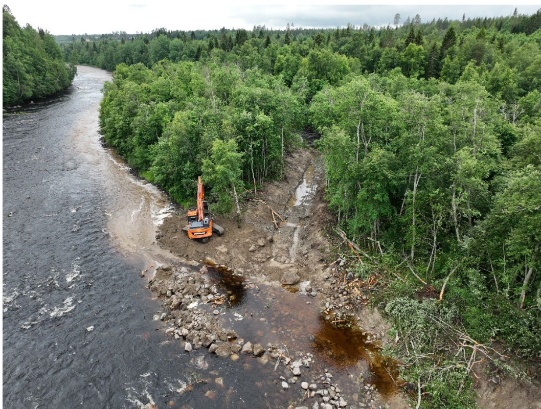
Figur 7. Överblicksbild (vinkel) från drönare på grävmaskin i arbete, Öreälvens huvudfåra. Här ger drönaren en tydlig överblick över arbetet då Öreälven är ett större vattendrag. Foto: Jonathan Nordin.
