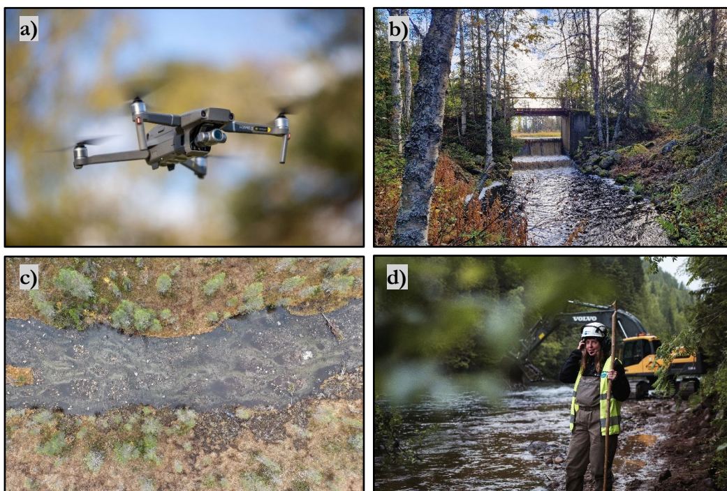
Figur 2. Drönare kan nyttjas som stöd i flera olika arbetsmoment vid restaurering av vattendrag. Till exempel vid bedömningar av kulturmiljöbedömningar (b), uppföljning (c) och arbetsledning (d). Foton: Michael Hoffman (a), Johanna Hägglund (d) och Länsstyrelsen Västerbotten (b och c).
