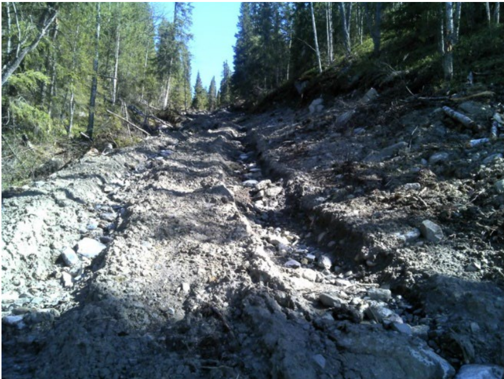
Ett exempel på bristande hänsyn mot mark och vatten som resulterade i erosion och lerströmmar ner i en bäck med Natura 2000-klassning. Markskadorna åtgärdades efter fototillfället. Foto: Kristina Nilson
