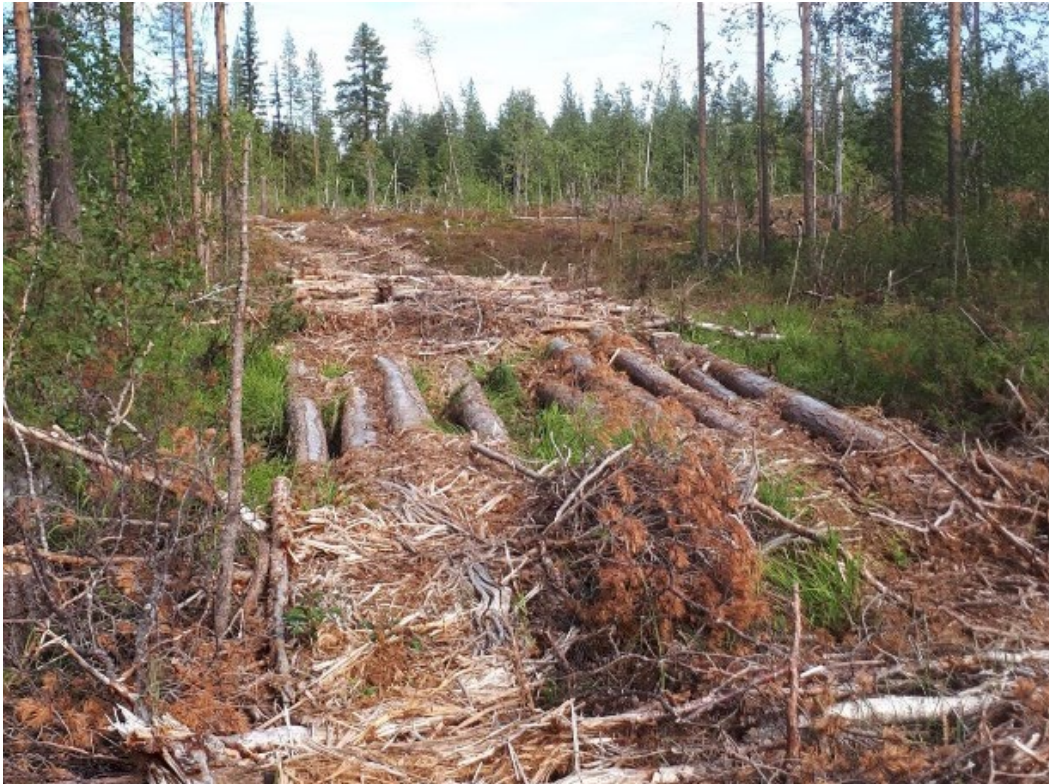
Ett exempel på en välgjord bro över en bäck som förhindrade körskador. Bilden användes som diskussionsmaterial under workshops. Foto: Ida Olofsson
