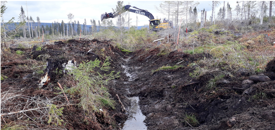
Dikesrensning med grävmaskin. Foto Ragna Lestander
