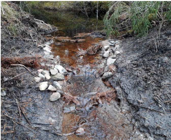
Figur 11. När vattnet kommer att rinna på erosionsbenägen mark eller över en dikesplugg kan det behöva erosionssäkras med stenar. På den här platsen bedömes det räcka med cirka 150 liter stenar med storleken 10–15 cm. Vid större flöden bör det finnas en del större stenar också.
