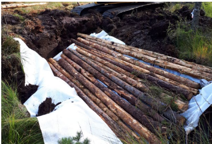
Figur 17. Robust och snabb plugg med geotextil och liggende rundvirke. Bredare, djupare än diket och diket fördjupning.
