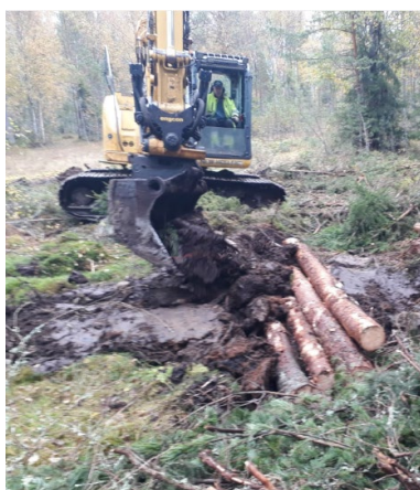
Figur 13. Förstärkning rundvirke respektive spontade plankor som stabiliserande struktur i pluggen.
