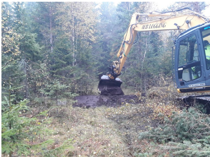
Figur 15. Torvplugg utan förstärkning.
