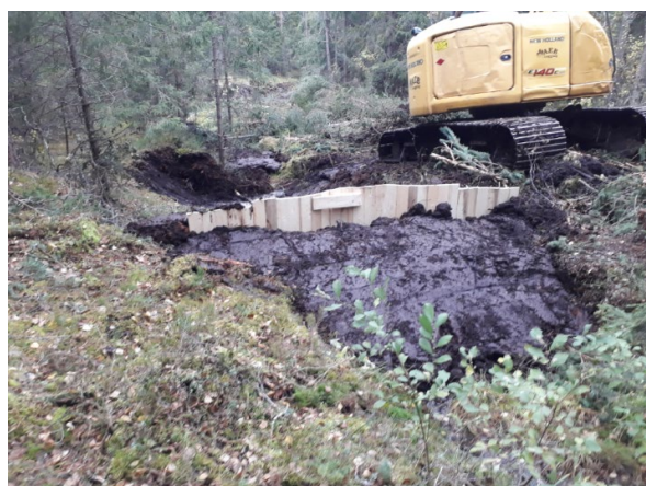
Figur 13. Förstärkning rundvirke respektive spontade plankor som stabiliserande struktur i pluggen.
