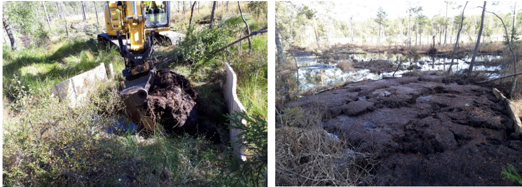
Figur 14. Torvplugg med dubbla palissader av spontade plankor som är så stor att grävmaskin behövs för att fylla upp den med torv.
