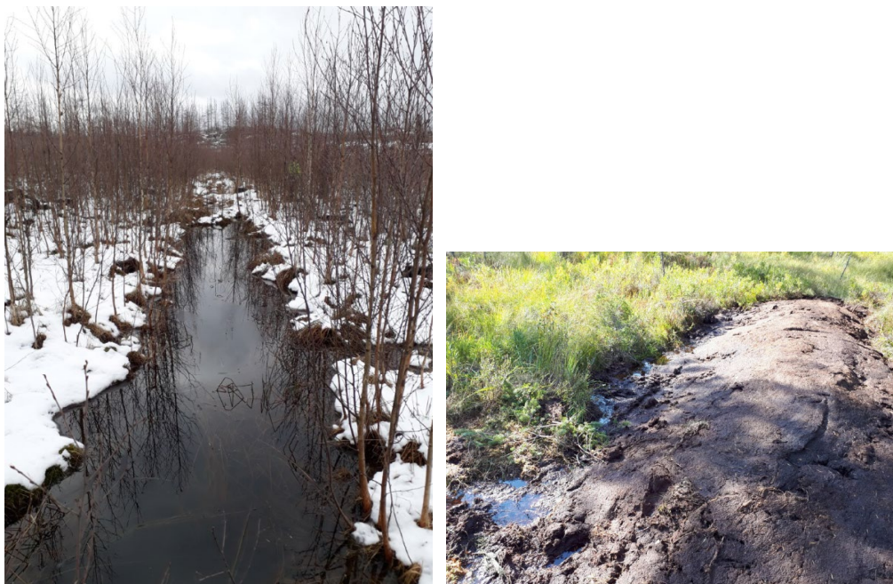
Figur 6. Till vänster: Här fylldes diket igen för några år sedan utan dikespluggar. Det såg jämt och fint ut vid åtgärdstillfället. Sedan har torven kompakterats 10–20 cm vilket lett till att en grund vattenfåra bildats där vattnet nu flödar snabbt igenom det igenlagda området. Till höger: En avledande torrvall som byggts tvärs över fördjupningen där diket gått så att vattnet styrs bort från fördjupningen och den gamla dikesfåran.
