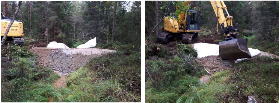
Figur 10. Plugg med mineraljord som förstärks med geotextil. Massor läggs även ovanpå geotextilen så att den inte utsätts för UV-ljus.
