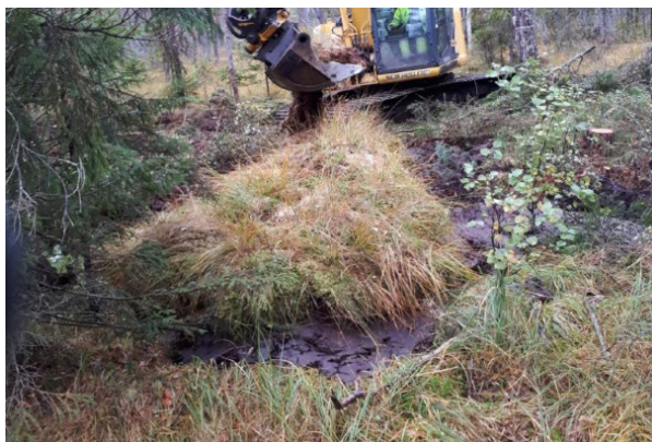
Figur 21. Dikesplugg med en vall tvärs flödesriktningen där vallen täckts med torvor av vegetation.
