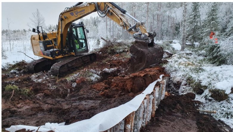
Figur 12. Stående palissad av rundvirke från platsen täckt med geotextil och sedan uppbyggd med torv. Foto: Tobias Eriksson
