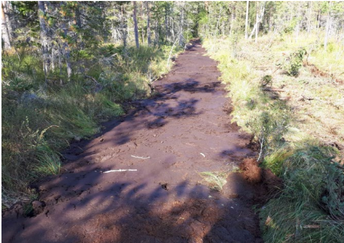
Figur 18. Igenlagt dike där torv tagits från gropar. Diket har lagts igen med liten råge, kanske 10 - 15 cm, så att vattnet inte kommer rinna just där.
