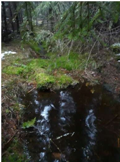
Figur 19. Dikesplugg av geotextil och rundvirke efter cirka 15 år. Överväxt av mossor och annan vegetation.
