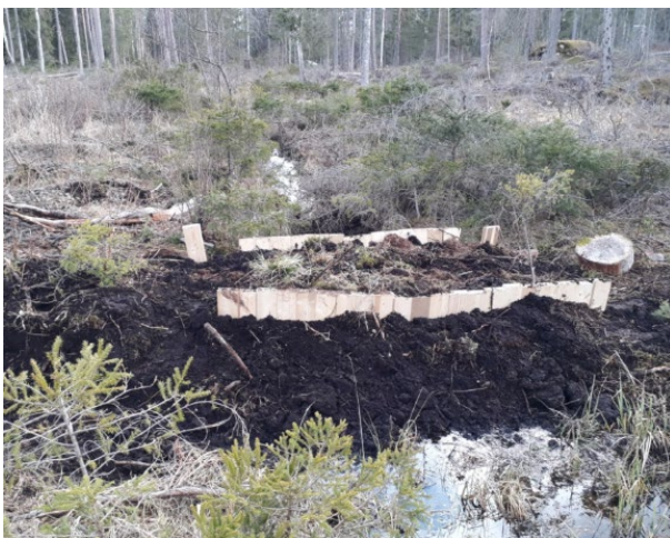
Figur 20. Handgrävd torvplugg med palissader.
