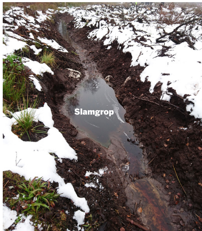
Figur 4. Exempel på slamgrop i tegdike. I slamgropar sedimenterar framförallt grövre partiklar. Storleken på gropar varierar vanligen mellan 1 och 3 m 3 .
