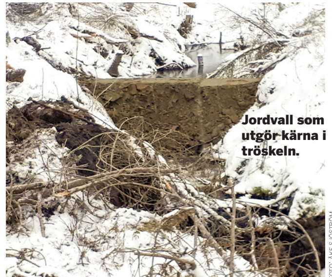
Figur 6. I detta dike har en serie av trösklar anlagts för att dämpa vattenhastigheten, vilket minskar risken för erosion i diket. Nedströms denna dikessträcka finns en sedimentationsdamm. Låg vattenhastighet gör sedimentationsdammen effektivare. En tröskel kan exempelvis göras med en jordvall (t.h.) som täcks med markduk, grus och sten.
