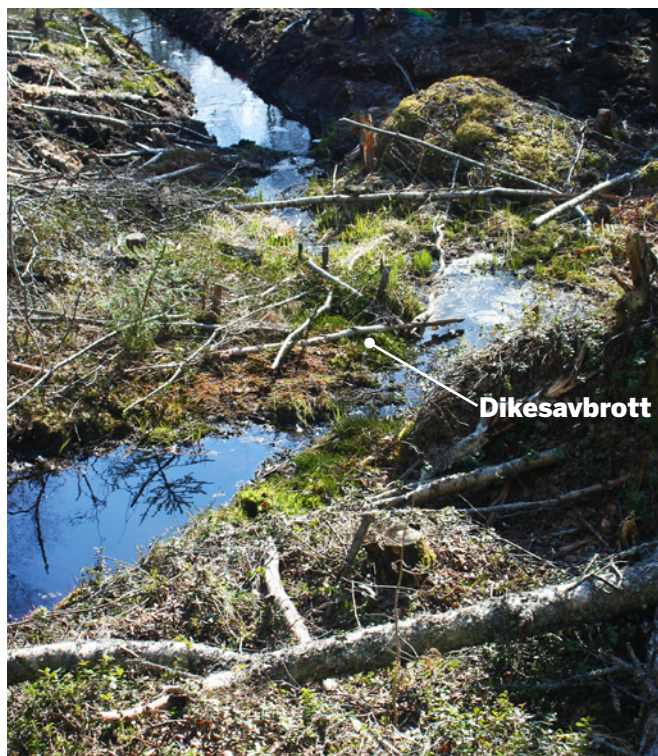
Figur 3. Genom att göra avbrott i rensningen på lämpliga ställen kan vattenhastigheten hållas så låg som möjligt. Här har de sista metrarna av tegdikedet lämnats orensade innan det ansluter till utloppsdikedet. Den orensade sträckan kan även fungera som ett kort översilningsområde.
