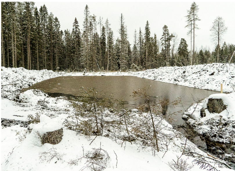
Figur 5. Exempel på rektangulär sedimentationsdamm som avslutas med gaffeldike innan översilningsområde. Om stora dammar anläggs i närhet till bebyggda eller ofta besökta områden bör varningsskyltar sättas upp.
